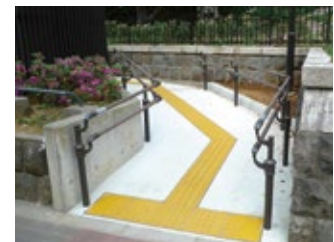
スロープにユニバーサル仕様の手摺を設置
