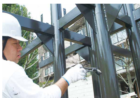
古い桟木を外して支柱のメンテナンス
