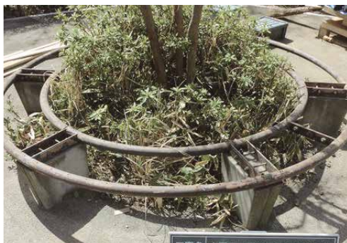
古い座板の撤去
