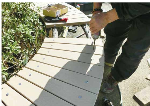
新しい座板の設置
