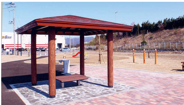
ガルバリウム鋼板屋根 青森市 成瀬公園 (青森県)
