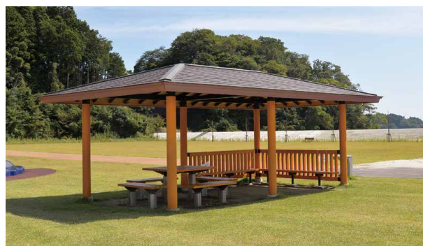
桧磨き丸太柱 袖壁付 南三陸町 南三陸ハマレ広場 (宮城県)
