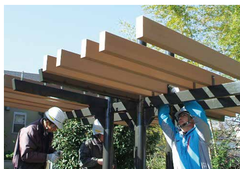
新しい桟木を設置
