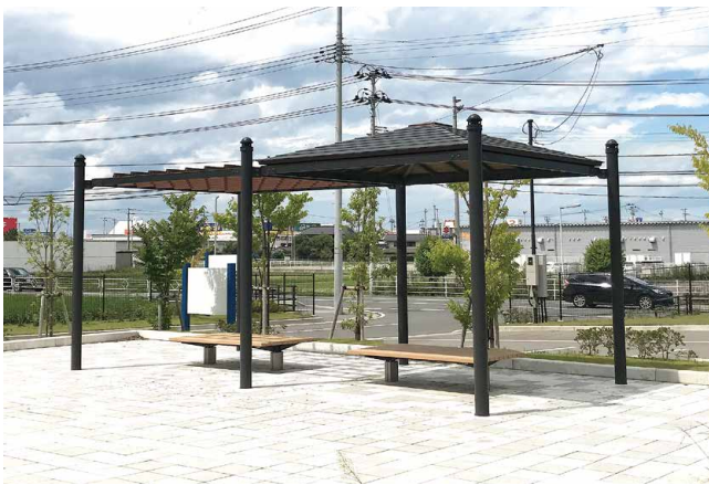
コロニアル屋根 県営復興公園住宅 北原団地 (福島県)
