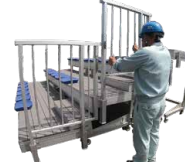
3 フェンス、5段目を取付
