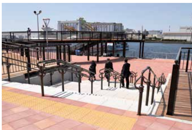
FE1-C2R・FE1-F2WA 千葉市 ケーズハーバー (千葉県)
