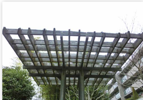
パーゴラ修繕前
