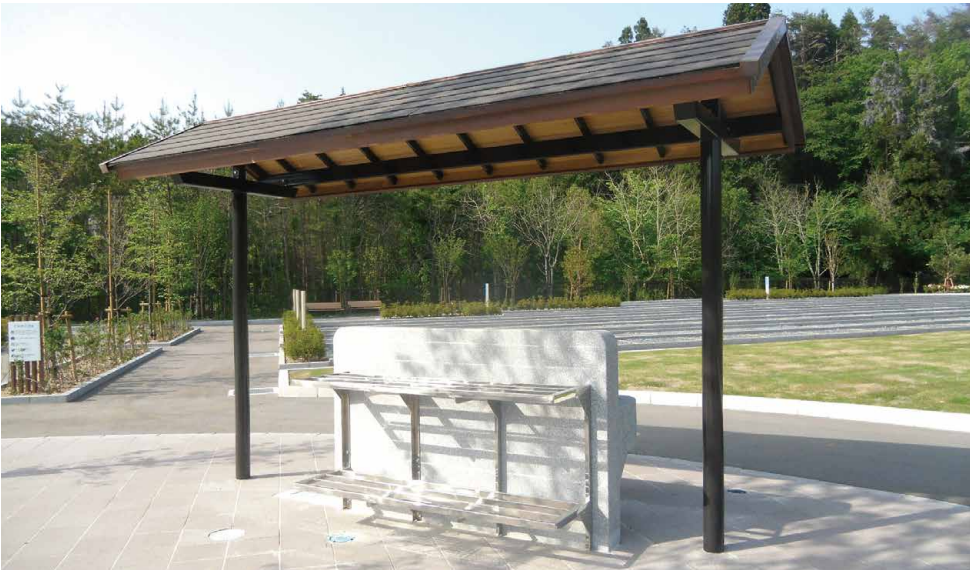
手桶棚(反対側は洗い場になっています) 気仙沼市 鹿折公営墓地(宮城県)
