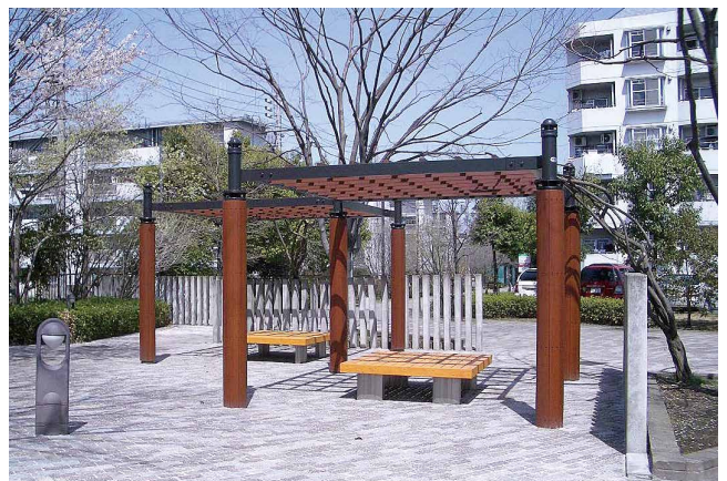
天然木材張り柱 UR 都市機構 西大和団地 (埼玉県)
