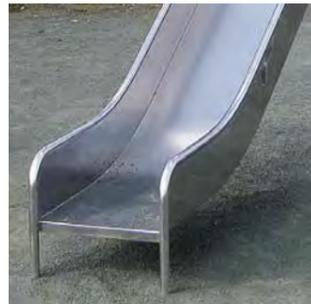
普通鋼の耐食性向上の目的で開発された合金です。中でもSUS304は、耐食性、加工性、溶接性、美観に優れ、表面仕上げも塗装の他、ヘアラインから磨きまで素材感を活かした様々な表情が選べます。遊具では、主にすべり台のすべり面などに使用しています。
