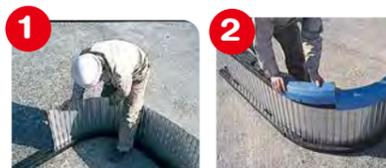
ステンレス板をプラスチックフレームの溝にはめ込む。コーナーガードロムをプラスチックフレームにはめ込む。
