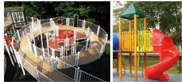
地域の伐採材を粉砕しリサイクルした合成木材を遊具のデッキに使用した事例(横浜市 こども自然公園:左)と、間伐材を遊具に使用した事例(右)。
