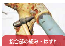
消耗部材の劣化
