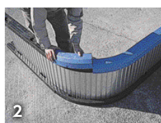
2 コーナーガードロムをプラフレームにはめ込む。
