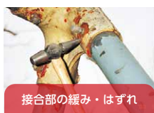
消耗部材の劣化
