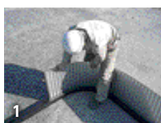
1 ステンレス板をプラフレームの溝にはめ込む。
